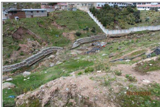
Fotografía 1: Deslizamiento del talud, de los muros tipo gavion en el río San Jose en el sector Huayllay.
